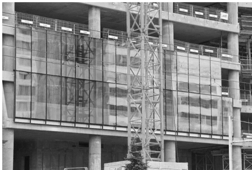
Rys. III.7.3. Fasada zunifikowana budynku wysokościowego [58]
