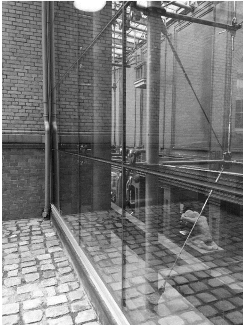
Rys.III.7.6. Fasada bezramowa z mocowaniem punktowym (fot. Michał Wojciechowski)
