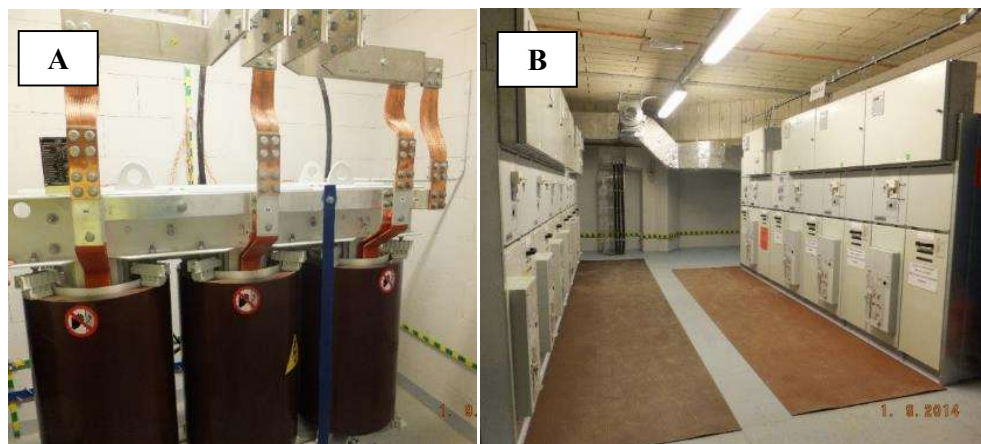
Rys. III.9.4. Nowoczesne systemy dystrybucji średniego napięcia: A/ rozdzielnia SN oraz B/ transformatory (fot. Michał Wojciechowski)
