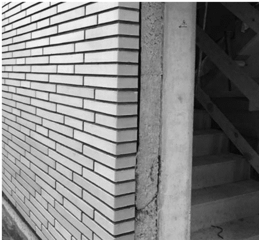
Rys. III.7.9. Trójwarstwowa fasada ceramiczna (fot. Michał Wojciechowski)
