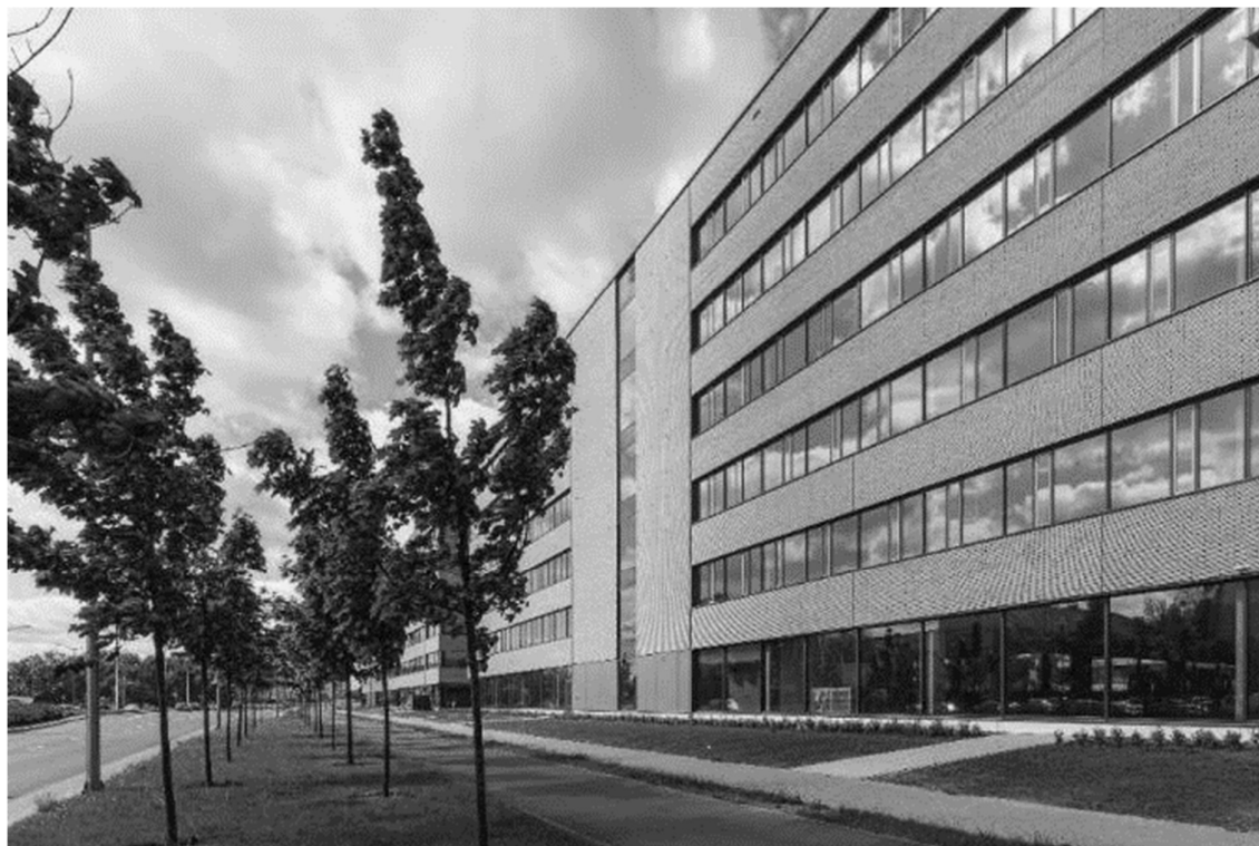
Rys.III.7.10. Nowoczesna fasada ceramiczna budynku biurowego (fot. Michał Wojciechowski)
