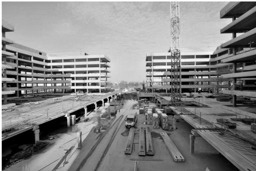
Rys. III.6.4. Konstrukcja prefabrykowana budynków biurowych (fot. Michał Wojciechowski)
