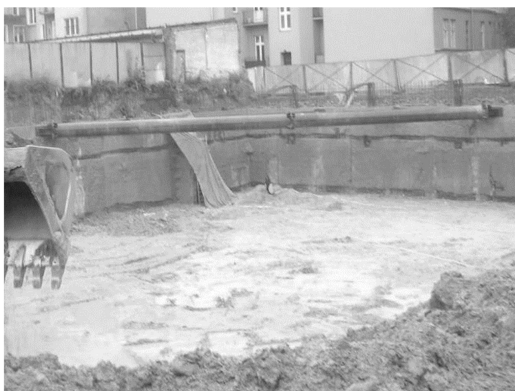
Rys. III.6.1. Ściana szczelinowa wraz z grodzicą rozporową (fot. Michał Wojciechowski)
