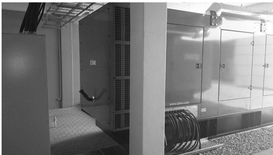
Rys. III.9.1. Agregat zasilania awaryjnego (fot. Michał Wojciechowski)
